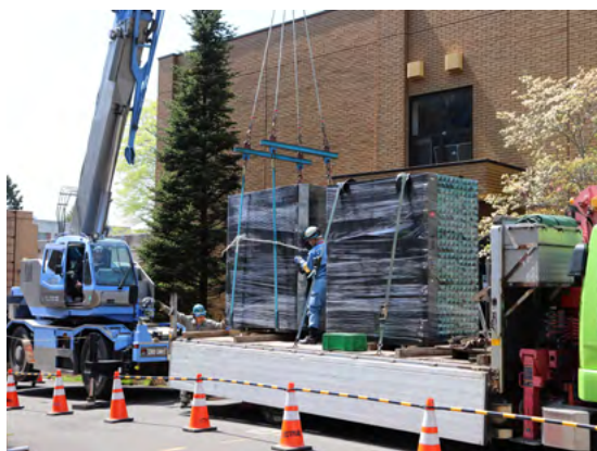
撤去され積み込まれるSR16000 (4月18日)
