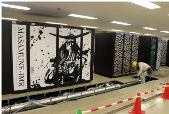
水冷配管の撤去作業（10月1日）
