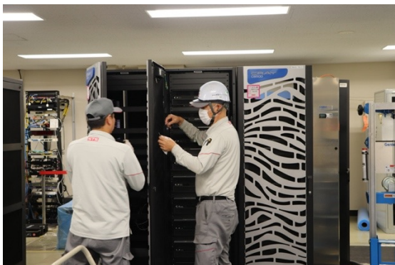
CS-Stormの解体作業（10月23日）
